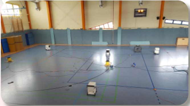
Dieses rächte sich bei dem Starkregeneignis vom 22.06.2023. Vor der Halle sammelte sich das Regenwasser und drang durch die Haupteingangstür in die Halle ein. Das Unwetter war in diesem Tag derartig stark, dass Regenwasser durch das Hallendach eindrang und innen an der Nordwand in die Halle hinein lief. Anscheinend waren die Regeneinläufe im Dach den Wassermassen nicht gewachsen. Die
